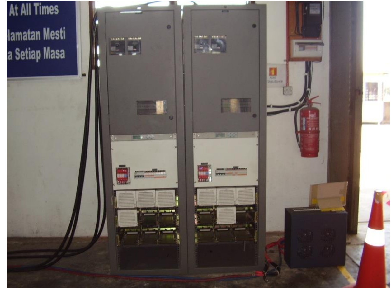
Rectifier System – สถานีอัดประจุแบตเตอรี่
